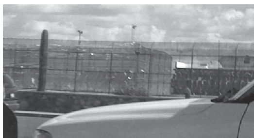
Bildet tatt ut av bilvinduet fra parkeringsplassen. Fengelet er omgitt av høye elektriske nettinggjerder med massevis av piggråd
